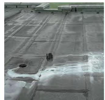
*Las aplicaciones típicas de Luminat son, por ejemplo, las inspecciones de tejados planos para localizar puntos de fuga mediante una prueba de coloración.*
