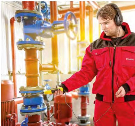
En bombas y otras máquinas de trabajo pueden detectarse a tiempo señales de desgaste mediante una sonda de sonido propagado por estructuras sólidas.
