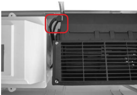
Fig. 7.4.2.6: Conexión del enchufe del ventilador
